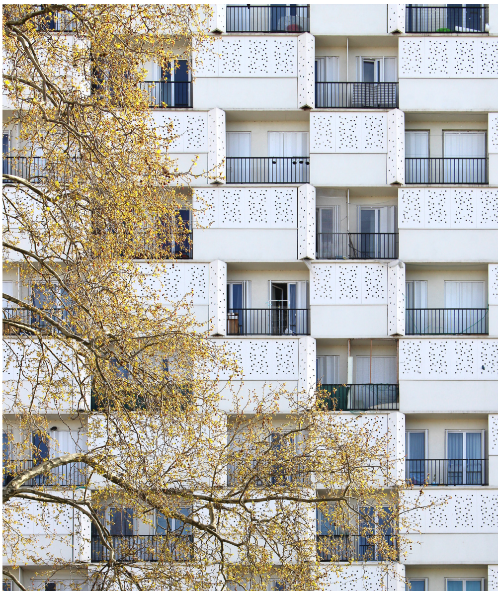
Tour des Résédas, quartier du Parc (cliché VOX)
