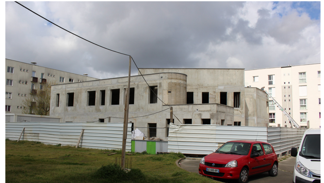
La mosquée en construction (cliché VOX)
