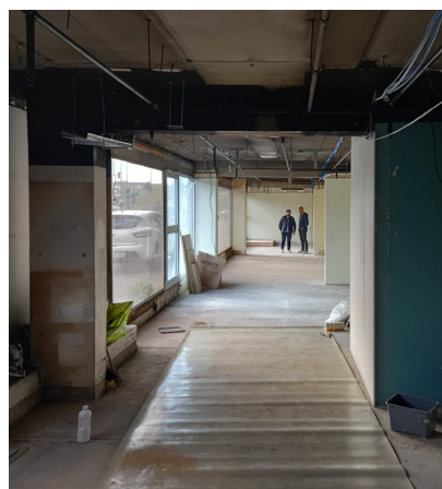
Existant - vue intérieure
