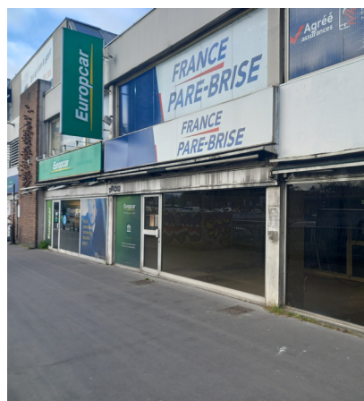
Existant - vue extérieure
