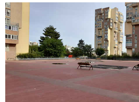
Dalle du parking en surface
