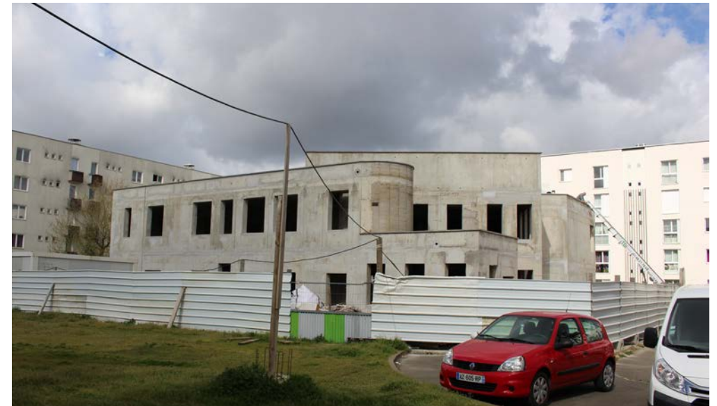
La mosquée en construction (cliché VOX)
