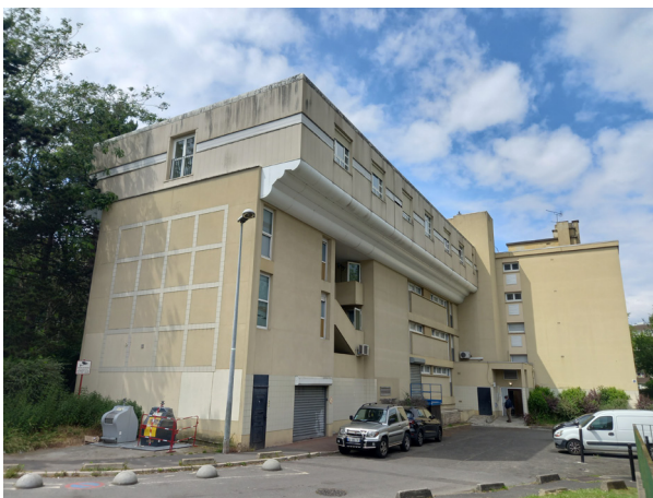
Vue de l'ancien EHPAD depuis le sud
