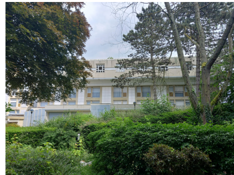
Vue de l'EHPAD et de son patrimoine paysager depuis l'ouest
